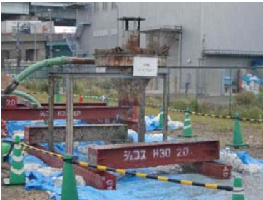
写真1 気中投入用サイクロン
