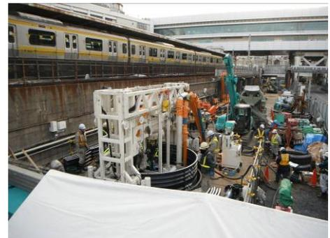
写真-2 杭施工状況
