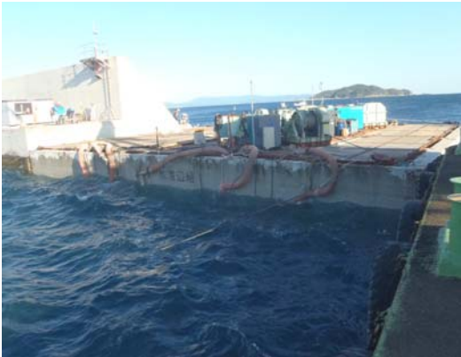
写真-1 ケーソン誘導状況
