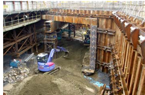
図-6 施工状況写真(函体内掘削途中時点)
