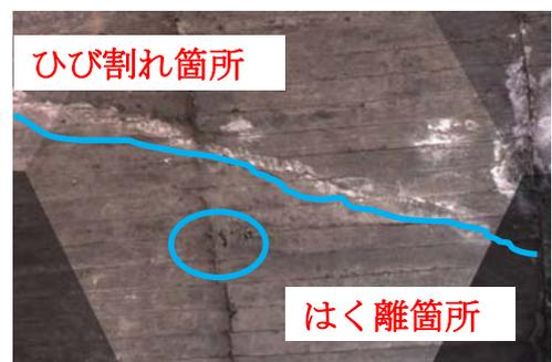
写真-2 トンネル内空断面写真
