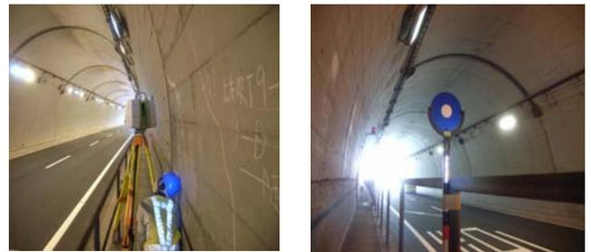
写真-1 3Dレーザースキャナーによる計測状況(器械を監査路に設置)
