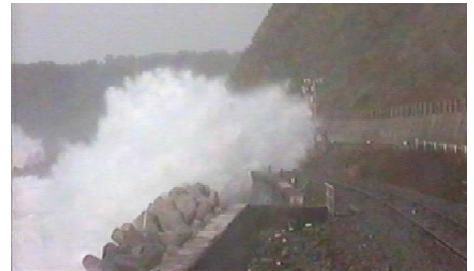
写真－1 五能線における冬季の越波状況
