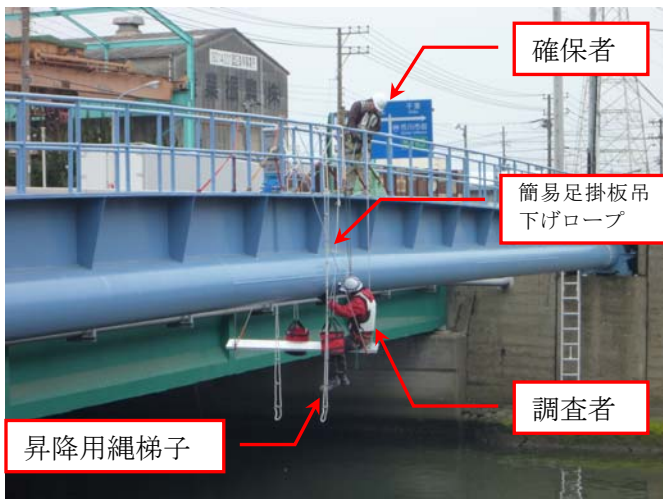
写真－2 調査状況
