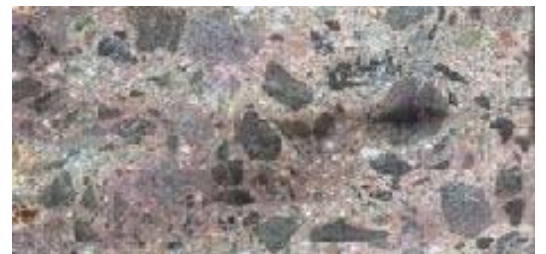
図-6 スキャン画像の一例（一般コンクリート）
