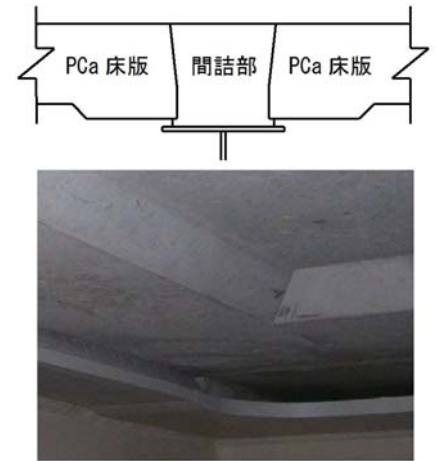
図-1 間詰部の状況
