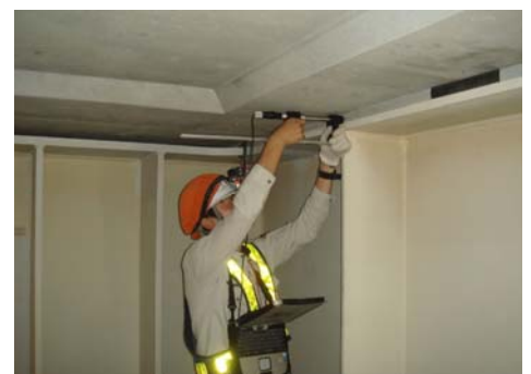
写真-4 点検の状況
