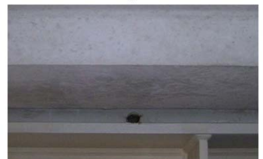
図-3 点検孔概況
