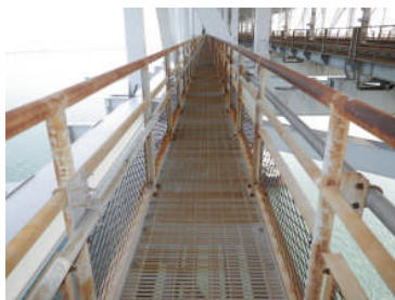
写真-1 瀬戸大橋の管理路
