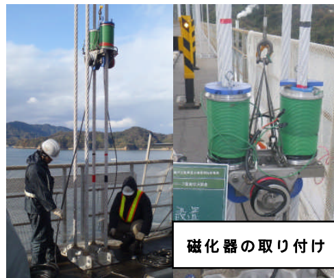
写真 - 1 測定状況(大島大橋)
