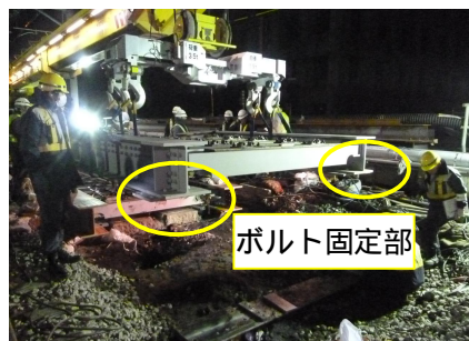
写真-1 鋼桁架設状況
