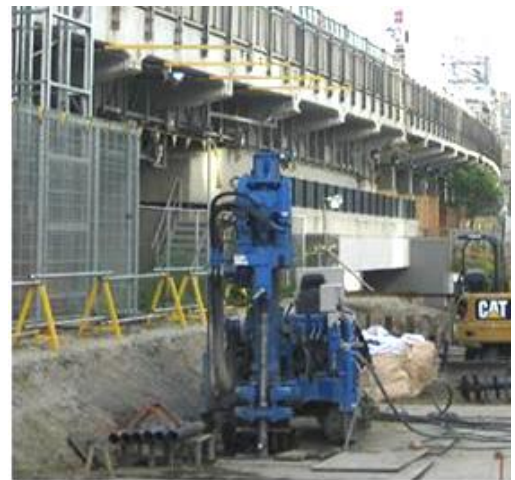
写真-1 e-コラム工法施工状況
