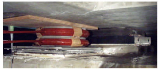
写真-3 フラットジャッキ使用状況
