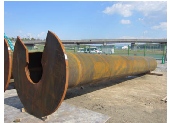
図 2 鋼管回転杭
