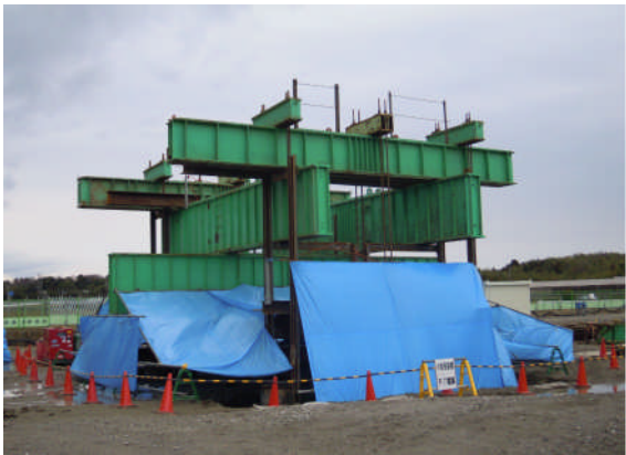
図 5 押し込み载荷試験実施状況
