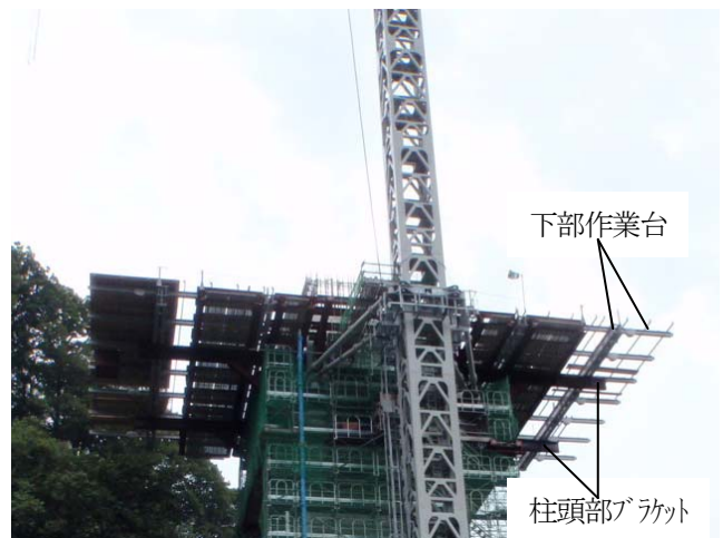
写真-1 ブラケット作業床組立状況
