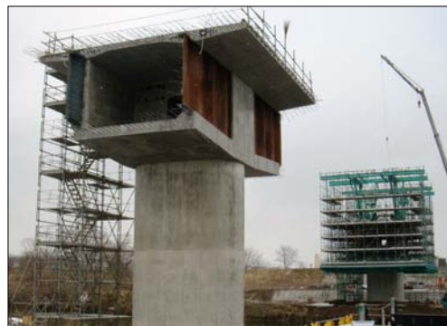
写真-1 P2 橋脚柱頭部
