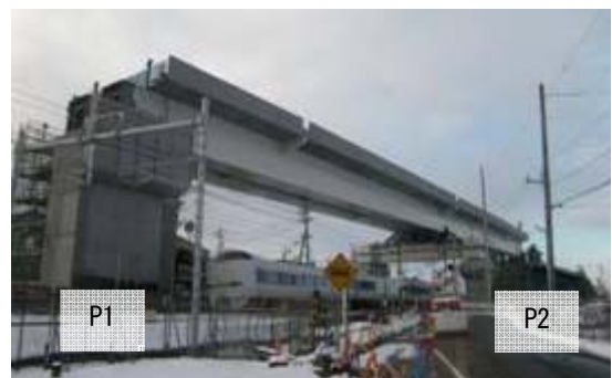
写真-2 架設完了写真
