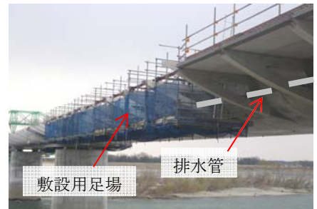
写真-1 水道・排水管敷設用足場
