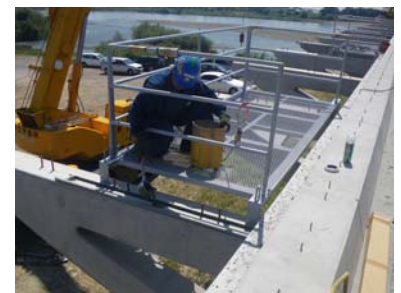
写真-3 作業デッキ
