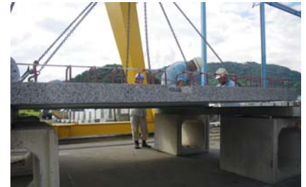
写真-2 PC板敷設試験(工場試験)
