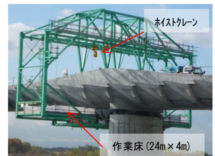
写真-4 PC板敷設作業車
