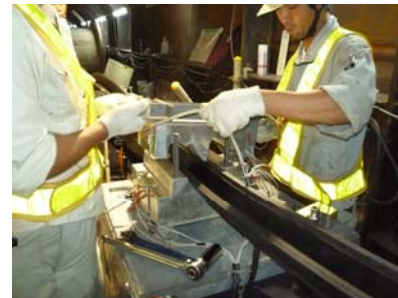
図－6 接続（圧着）状況
