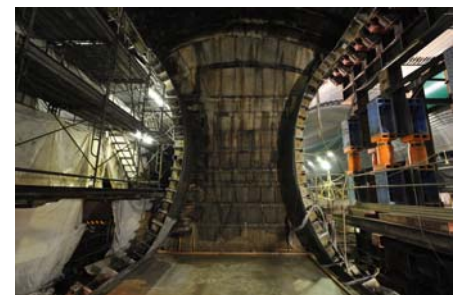
図－７ 地下切開き施工完了全景
