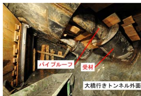
図－６ 到達側接続構造設置状況
