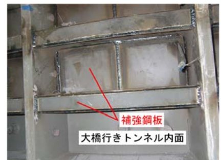
図－６ 到達側接続構造設置状況
