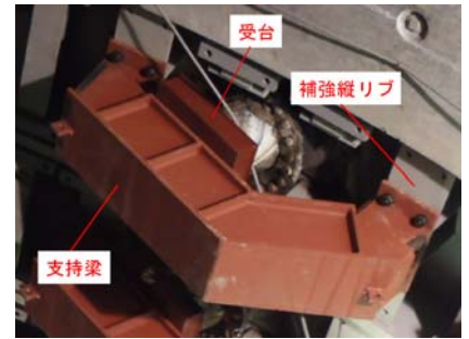
図－４ 発進側接続構造
