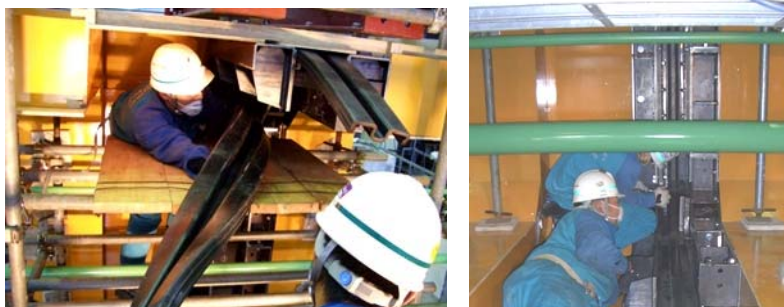
図-7 天端ゴム引き込み状況（左） 底版セグメント取り付け状況（右）
