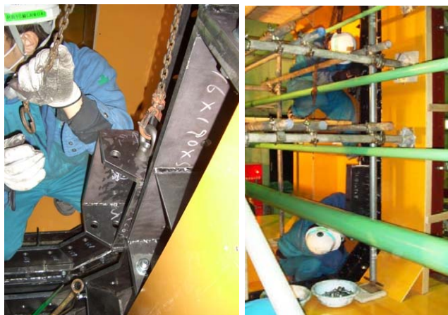
図-6 側壁作業状況 セグメント吊り上げ状況（左） 組立状況（右）
