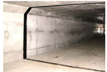
図-2 耐震ジョイント(完成時)
