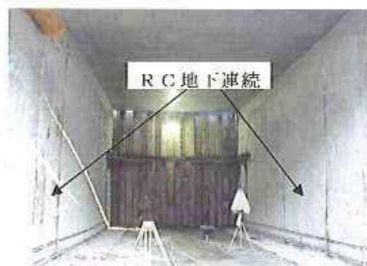
写真-3：構築完了後のRC地下連続
