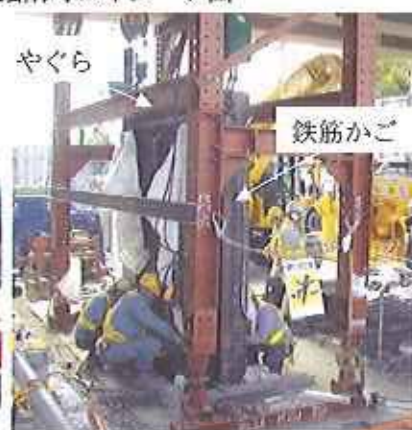
写真-2：鉄筋かご設置
