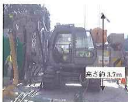
写真-1：TMX 掘削
