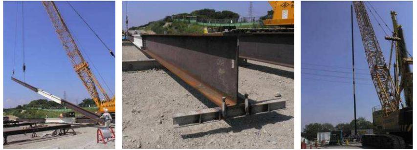
写真-1 立起し      写真-2 転倒防止治具      写真-3 建込み
