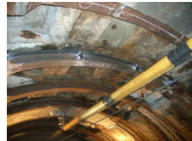
写真-5 リングビーム交換完了
