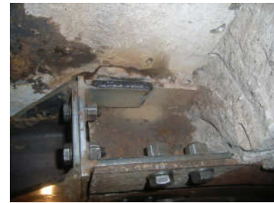
写真-4 連結金具溶接完了
