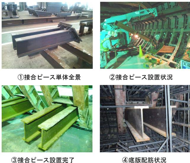
写真1 接合ピース施工状況
