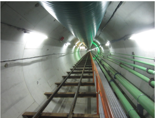
図-6 組立後のセグメント
