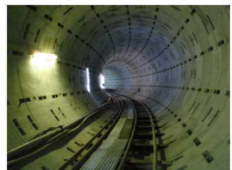
写真-3 合成セグメントの状況
