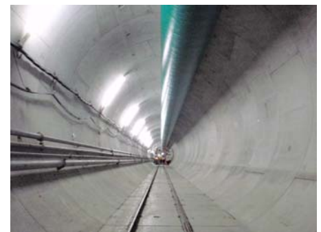
写真-2 RSF セグメントの状況
