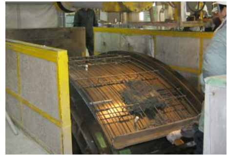
写真-1 RSF セグメント打設状況
