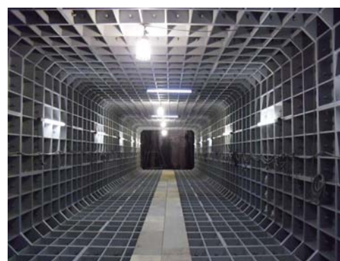
図-5 トンネル一次覆工完了状況
