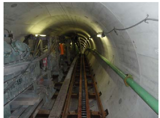
写真-1 洞道内急勾配部
