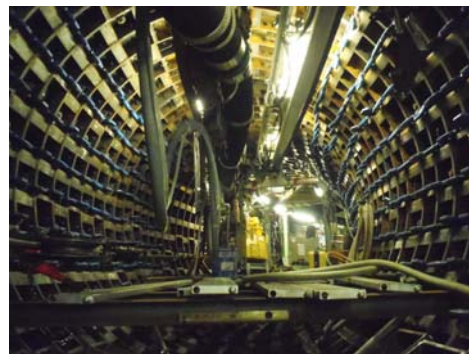
写真-1 急曲線部施工状況
