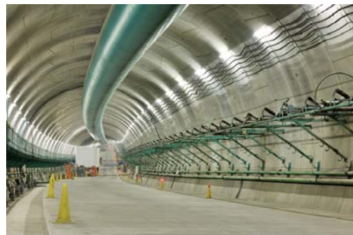
写真-1 坑内全景
