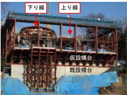
図-9 下り線仮設構台全景
