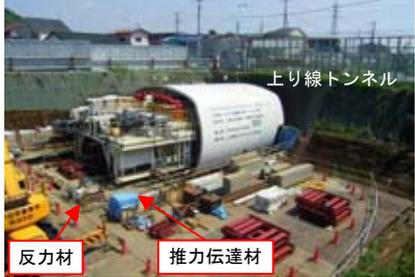
図-4 上り線シールド発進状況
