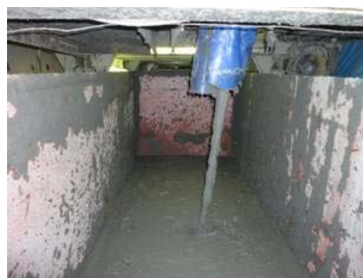
写真2 掘削土の排出状況
