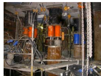
写真-2 鋼管圧入状況
