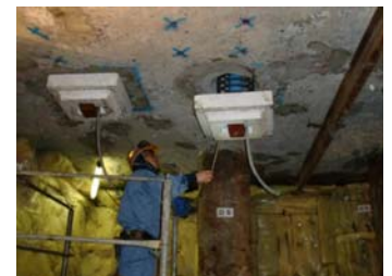
写真-1 新設アンカーボルト挿入
