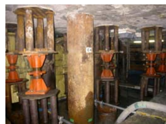
写真-4 新設基礎杭完了
