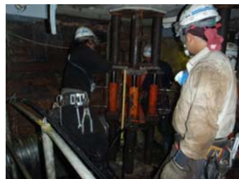
写真-3 プレロード荷重導入
