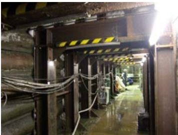
写真-2 横坑・導坑
