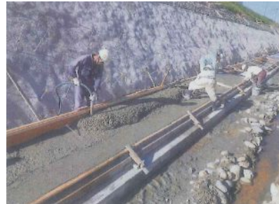
写真-3 施工状況
