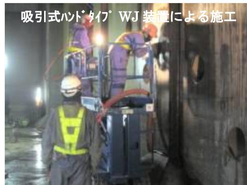
写真-3 施工状況（塗膜除去）
