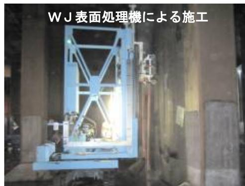
施工結果から、WJ 表面処理機による施工は、人力によるハンドタイプ WJ 装置よりも処理能力が約 1.4 倍高かった。また、WJ 装置の飛散防止機能によって WJ 作業時に発生したミストや粉塵などは吸引され、大幅な作業環境の改善が図れた。
