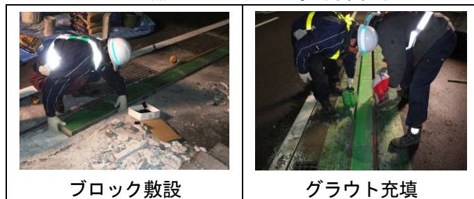
写真-3 施工状況
