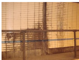
写真-1 内装工の汚れ・タイル剥落状況
