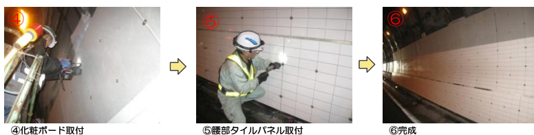
写真-2 TFタイプ施工手順
