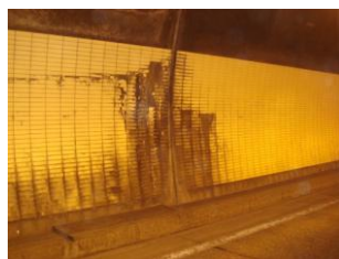
写真-1 内装工の汚れ・タイル剥落状況
