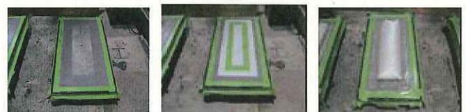
写4 接着剤下塗り 写5 防水シート貼付 写6 防護ネット設置
