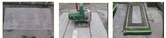
写1 止水堰位置墨出し 写2 止水堰切削 写3 プライマー塗布
