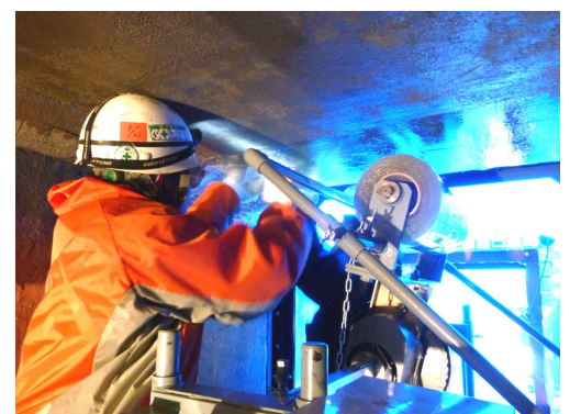
図-7 水路2 施工状況
