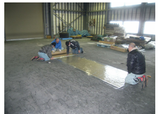
図-5 シート加工状況
