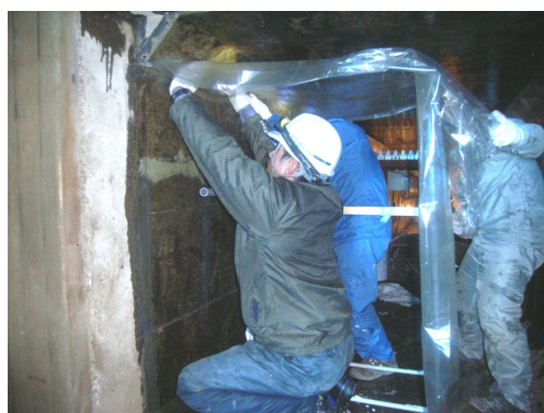
図-6 水路1 施工状況
