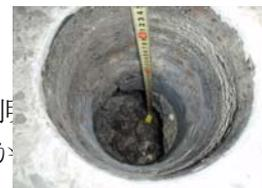
写真-1 空洞状況の確認
