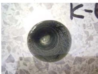
写真-4 確認孔による注入状況
