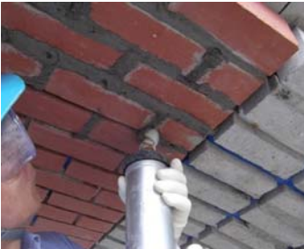
写真-4 施工性確認状況
