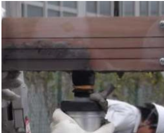
写真-5 充填深度確認状況
