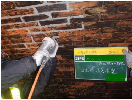
写真-6 目地充填状況
