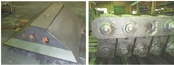
写真-3 固定支承とローラー連結板（ブラスト後）
