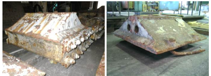
写真-2 可動・固定支承(撤去後)
