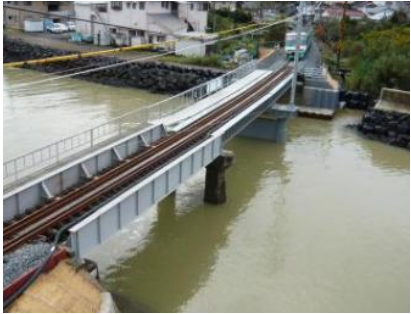
写真-2 橋りょう復旧状況
