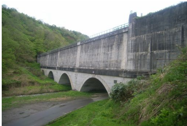
写真-1 水路橋全景
