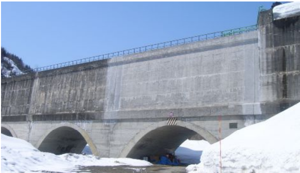
写真－3 施工後の状況
