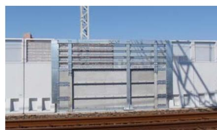
写真-4 鋼製下地+ボード+有孔折板 (案2)
