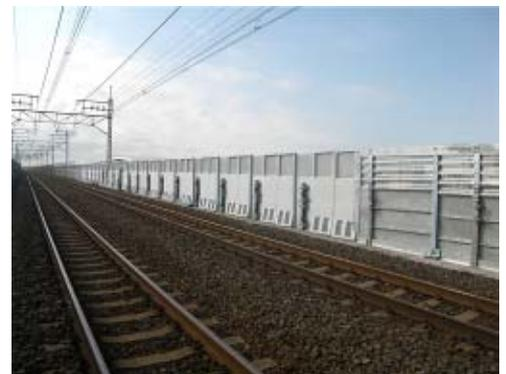
写真-1 一体型 FRP 防風柵設置全景
