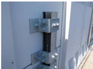
写真-3 FRP 製塞ぎ板取付状況
