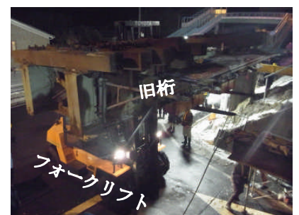
図 4 旧桁撤去状況
