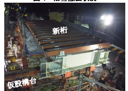
図 5 新桁架設状況
