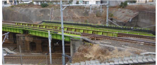
写真-1 橋梁全景
